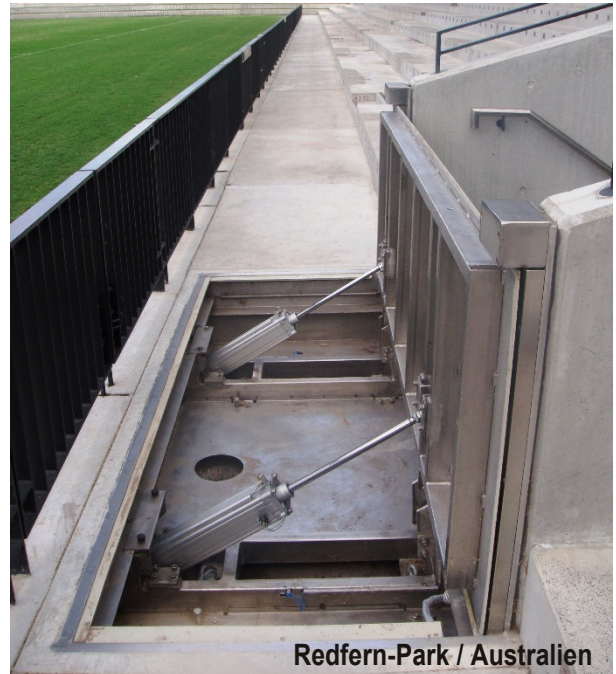
System im aktivierten Zustand
